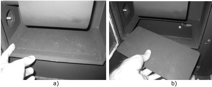
Figura 104 – limpeza do interior da salamandra
